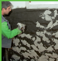
Ugradnja KÖSTER spric maltera
