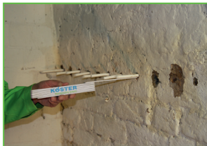
Ubacivanje KÖSTER Capillary Rods
