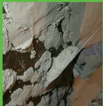
Ugradnja KÖSTER res- touracionog maltera
