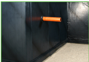
Hidroizolacija je ugradjena.
