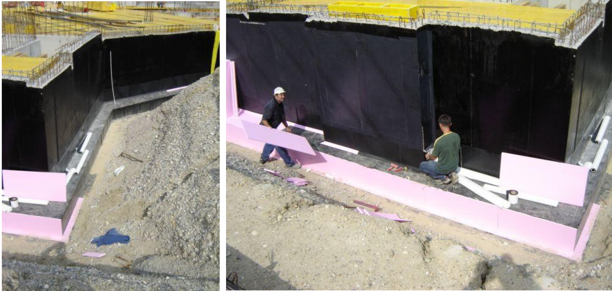
Aplikacija KÖSTER Bikuplan KSK AW 15 membrane (Geradsorf 2, Austria 2007)
