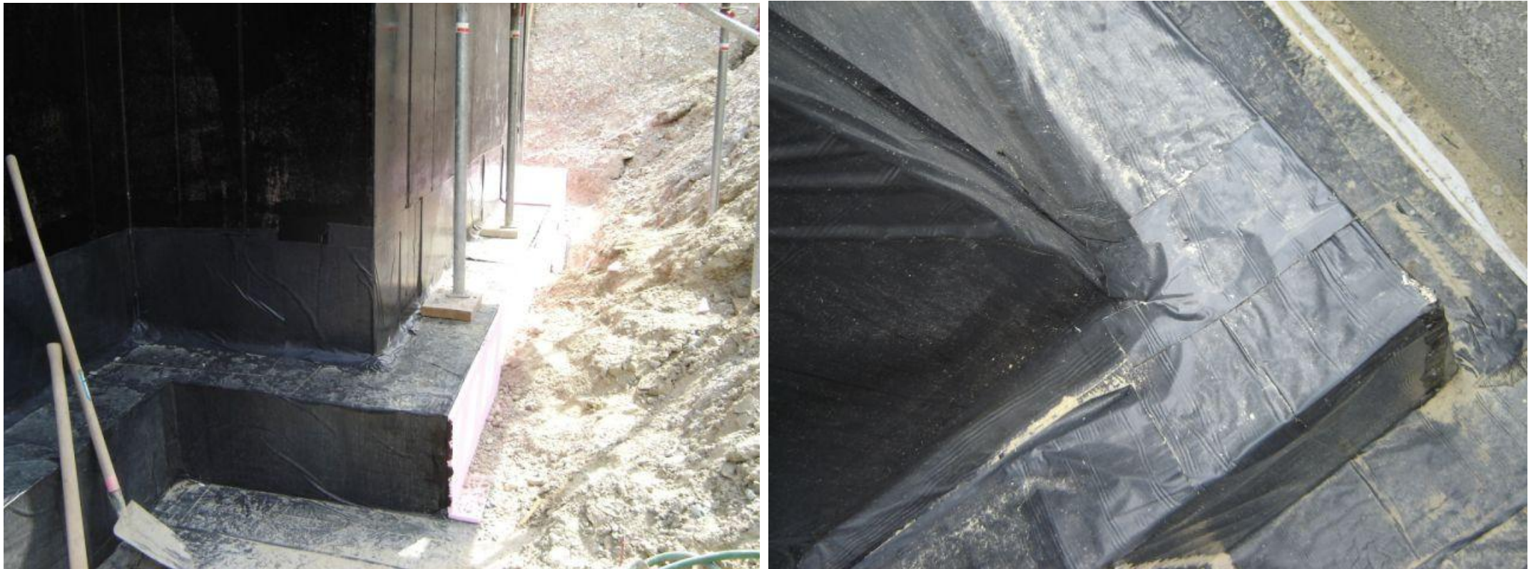
Aplikacija KÖSTER Bikuplan KSK AW 15 membrane (Geradsorf 2, Austria 2007)
