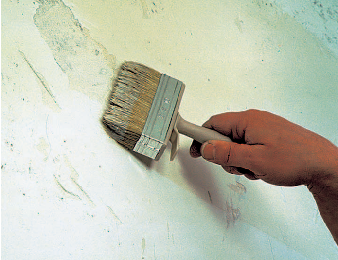
Abb. 3: Einstreichen der Grundierung mit Quast...
