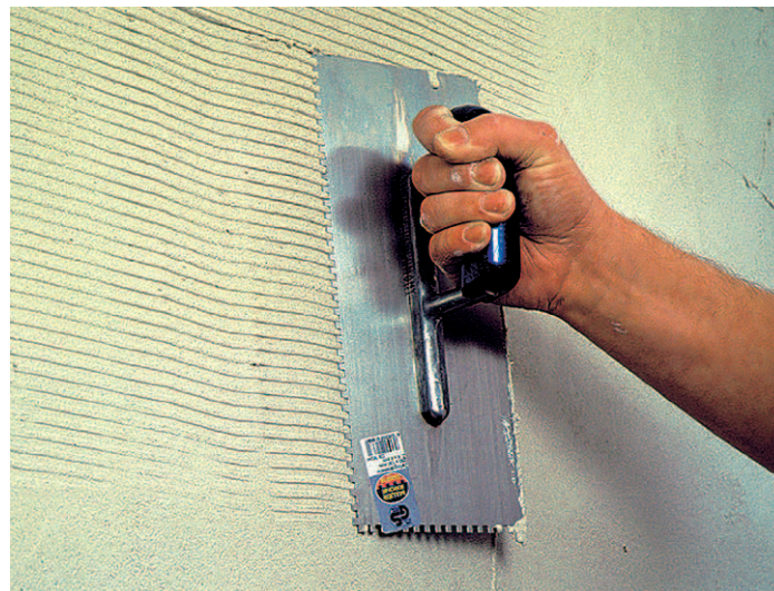
Abb. 5: ...dann drittens nach einer Stunde den Spezialputz aufbringen mit Zahnpachtel
