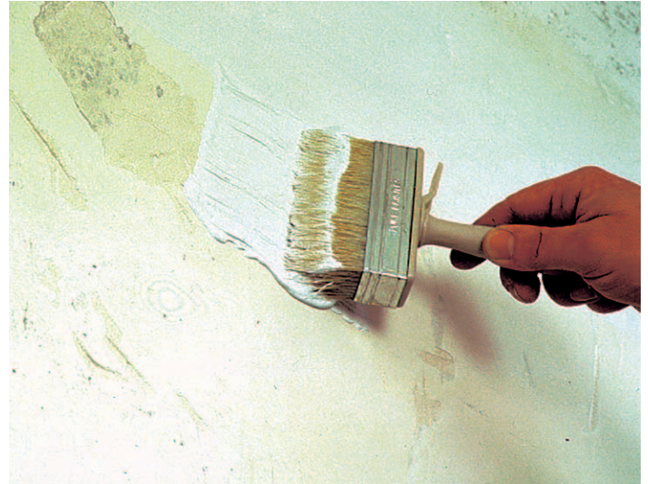
Abb. 4: ...und eine Viertelstunde später Streichfolie auftragen...
