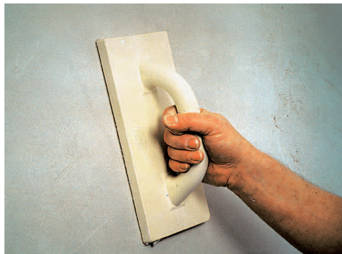
Abb. 6: Abschluss: Glätten mit Reibebrett – keine dampfbremsende Weiterbeschichtung vornehmen
