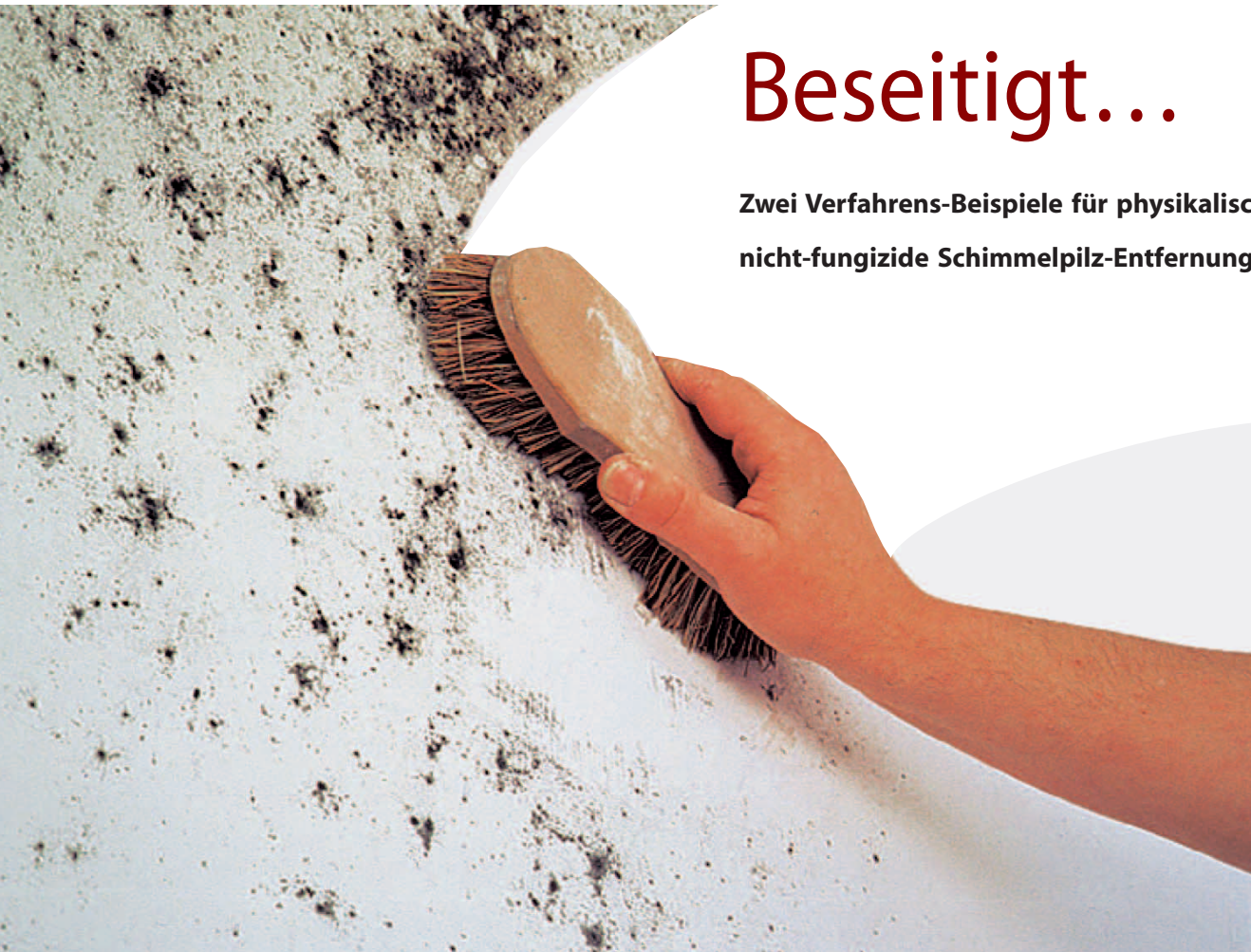
Erste Untergrundvorbehandlung: Schimmel entfernen mit Bürste oder Spachtel
