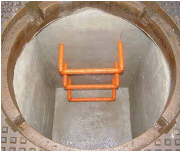
Mit KÖSTER Schachtmörtel sanierter Schacht
