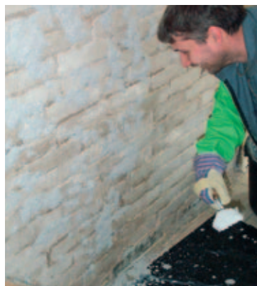
Spritzbewurfauftrag von KÖSTER Sanierputz weiß „schnell“.
