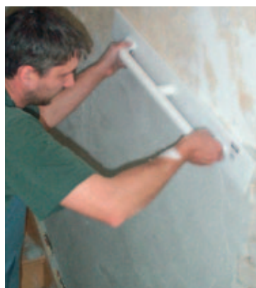
Nach dem Aufziehen wird der Sanierputz mit einer Kardätsche abgezogen ...
