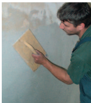
... und nach ausreichendem Anziehen abgerieben und geglättet.
