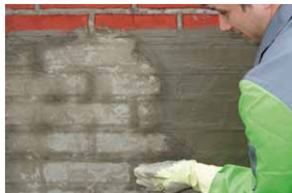
Das KÖSTER Kellerdicht 2 Blitzpulver wird per Hand in die frische, nasse Schlämme eingerieben, bis die Fläche trocken ist.
