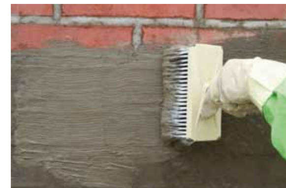
Direkt im Anschluss wird ein weiteres Mal die KÖSTER Kellerdicht 1 Schlämme aufgetragen. Dieser Schritt wird nach 30 Min. noch einmal wiederholt.
