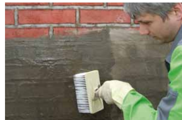
KÖSTER Kellerdicht 3 Härte-Flüssig wird ohne Wartezeit und mit einem sauberen Quast aufgestrichen.
