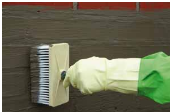
Die KÖSTER Kellerdicht 1 Schlämme wird mit einem Quast oder einer festen Bürste aufgetragen.
