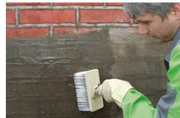
KÖSTER Kellerdicht 3 Härte-Flüssig wird ohne Wartezeit und mit einem sauberen Quast aufgestrichen.
