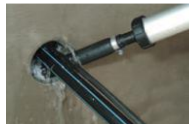
... Kabeldurchführung wird mit ...
